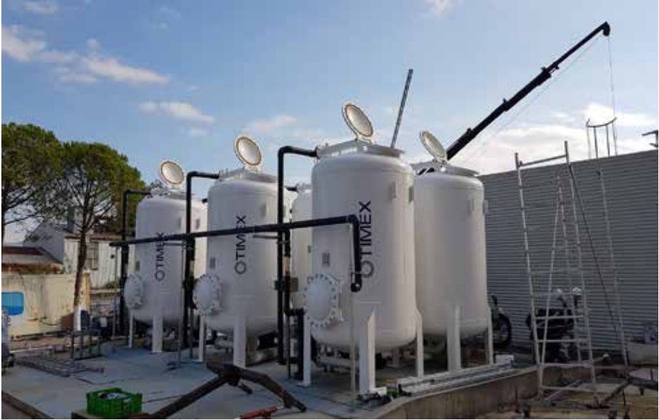
Şekil 6. TIMEX Kum Filtreleri
