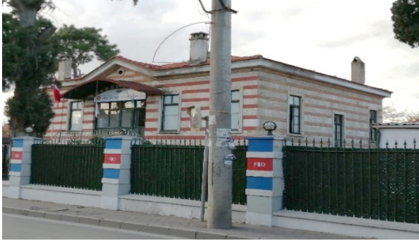
Res.18- Almaşık duvar teknikli konutun genel görünümü.
