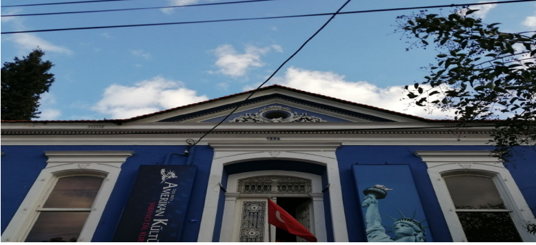
Res.36- Alınlık süslemelerinde alçı malzeme.
