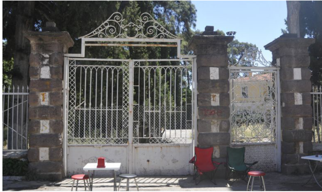
Res.19, 20, 21- Kapı ve pencerelerden demir korkuluk örnekleri.
