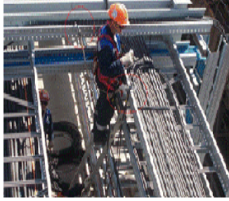
Ŗekil 1. Rafineri inŖaatındaki boru taŖıma hatları üzerindeki elle kablo çekme ve mekanik kuvvet ölçer
