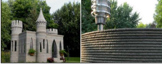
Ŗekil 2. (a) Yerinde basılan ilk yapı; (b) yazdırma ilerlemesi Kaynak: 3D Print Canal House, 2016.
