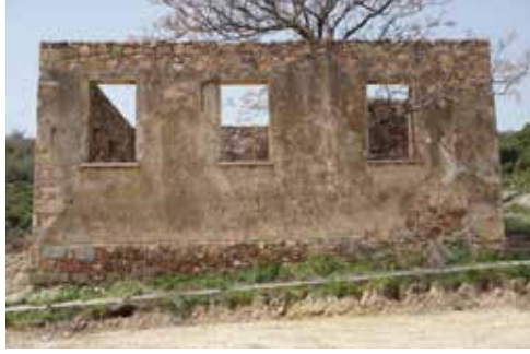
Res.2- Ürkmez İlk Mektebi, doğu cephe
