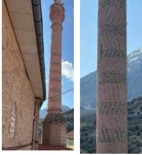
Görsel 10: Barla Çeşnigir Paşa Cami minaresi ve minare detayı (Çam, 2026)
