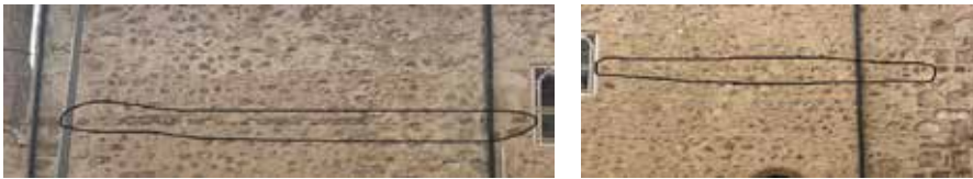
Görsel 9: Hızır Bey Cami Batı duvarı sağ ve sol bölüm sırlı tuğla çini detayı (Çam,2026)
