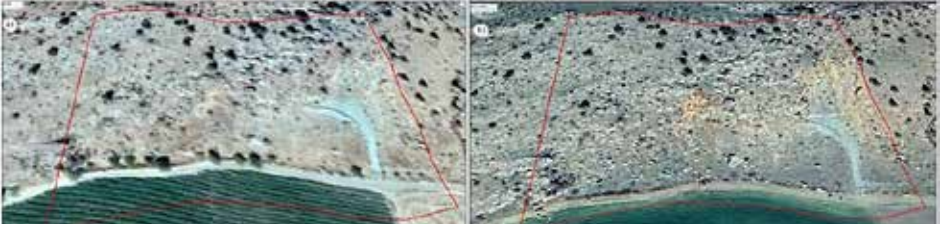
Şekil 9. Ozan kırsalı deprem öncesi saha durumu (a) ve deprem sonrası kaya ve moloz düşmeleri (b)
