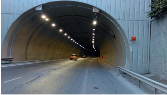
Şekil 5: Tünelin Giriş Bölgesi.
