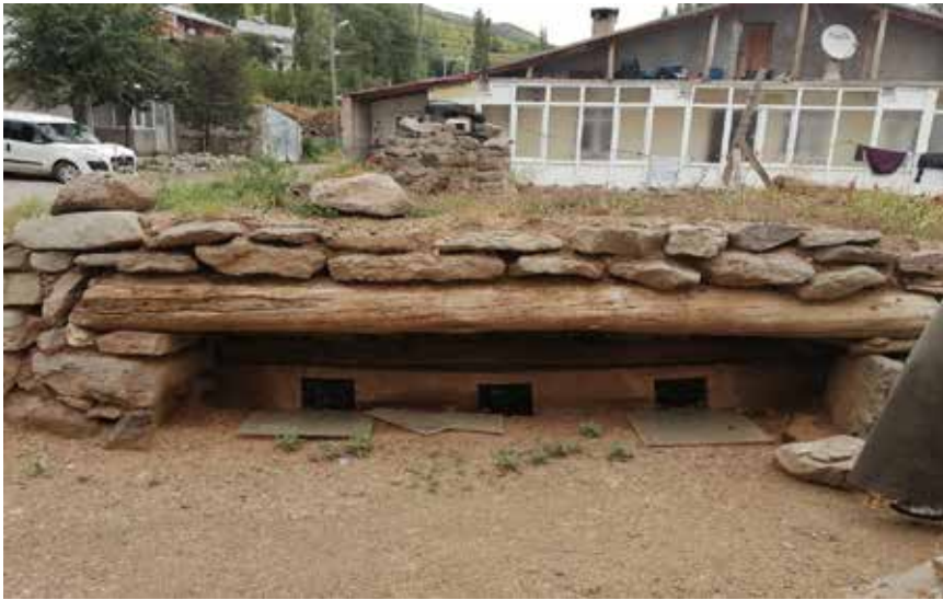
Şekil 9: Yer yüzeyi seviyesinde olan pencereler (“patha”) ve düz dam örtülü çatı. (Fotoğraf, Huzeyfe Şanlı, Posof).
