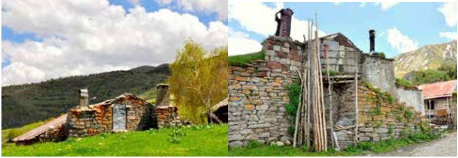
Şekil 6: Posof köylerinde evlerin beden duvarları arkasında yer alan “buhari” denilen bacalar.
