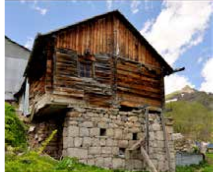
Şekil 4: Birinci katı taş, ikinci katı ahşap olan kırsal meskenler; Günbatan köyü, Posof.
