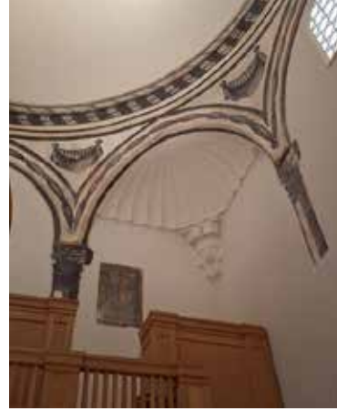
Görsel 6: Kadınlar Soyunmalık Bölümü Kubbesi Kalemışleri.
