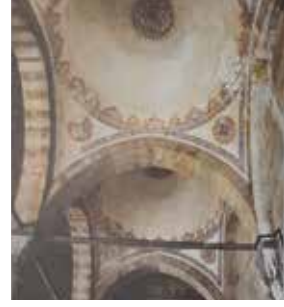
Görsel 15: Mihrimah Sultan Camii. Caminin Dış revaklarından Bir Görünüm.
