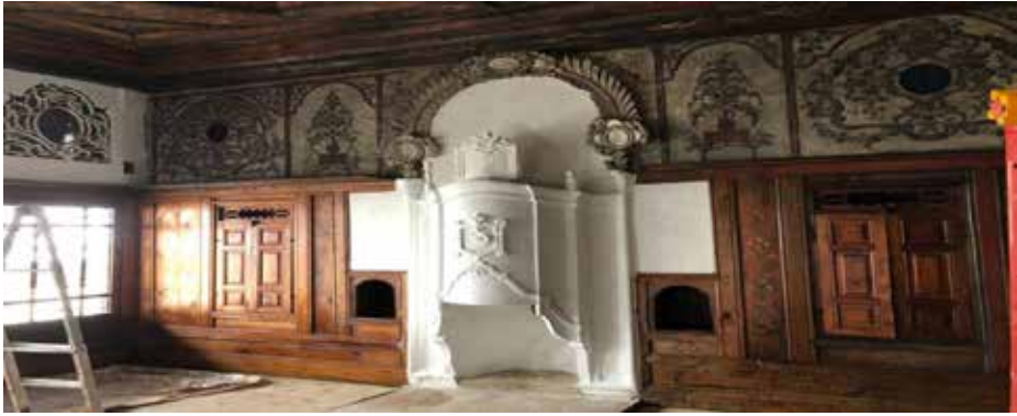
Görsel: 2 Toptaniler Konağı Başoda Duvar Resimleri
